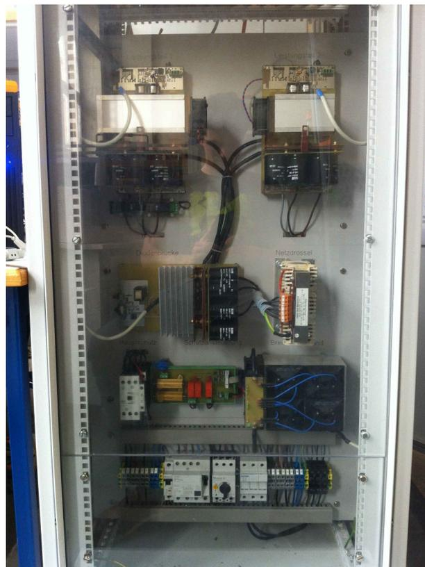
Abbildung 1.5.: Der Leistungsteil mit den beiden Kompaktumrichtern, Diodenbrücke und Netzdrossel, Hauptschütz, Vorladeplatine und Bremschopper, Einspeiseklemmen und Sicherungen (von oben nach unten)
